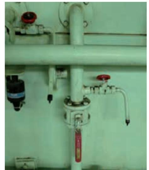
Entnahmestelle für die SDA-Ölproben
